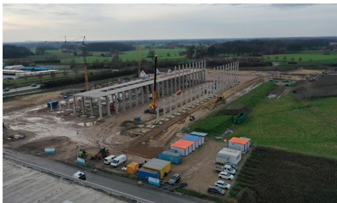
Das Gebäudeensemble auf der Baustelle im IBV ist schnell in die Höhe gewachsen. Zu Jahresbeginn ging es an den Kranbahnen und Stahlfachwerkträgern für das Hallenschiff weiter. Fotos: crayen bergedieck krasing architekten BDA | PartmbB
